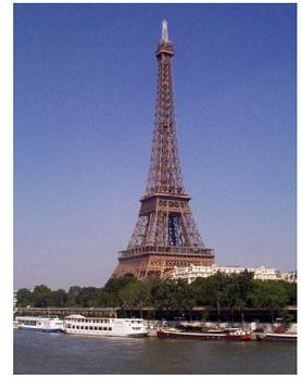
La hauteur de la Tour Eiffel est de 320,75 mètres. Elle pèse 7000 tonnes. Il y a trois étages (à 57 mètres, à 115 mètres et à 274 mètres).
